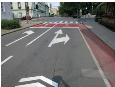
Slika 13: Primer izvedbe "Čakalne površine za kolesarje" oz. t.i. "Cycling box-a" na kraku semaforiziranega križišča (v kombinaciji z ukrepom souporabe voznega pasu / kolesarskega pasu)
