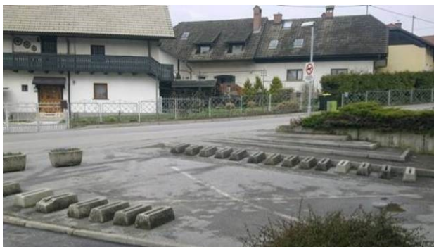
Slika 88: Neprimerna betonska stojala, ki ne omogočajo niti priklepa kolesa (Gregor Steklačič)
