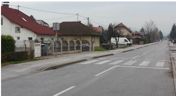
Slika 23: Primer neudobne kolesarske steze na Rakovi Jelši v Ljubljani, dviganje in spuščanje steze na vsakem dovozu za privatno hišo (vir:Gregor Steklačič)
