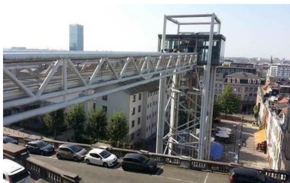
Slika 38: Kolesarsko dvigalo za premagovanje višinske razlike na kratki razdalji v Bruslju (Vir: Gregor Steklačič)
