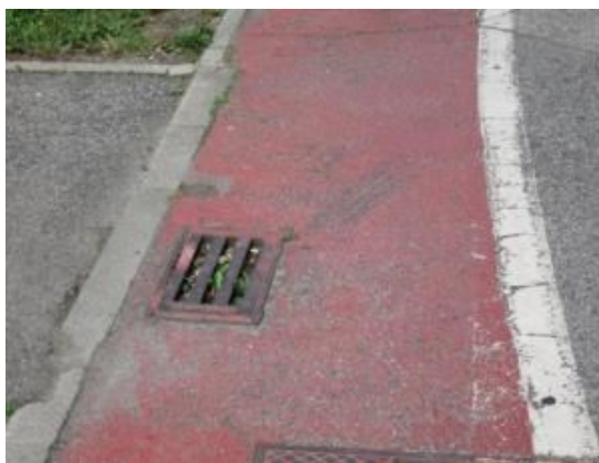
Slika 7: Primer neustrezne smeri rešetke vtočnega jaška na kolesarskem pasu (Lep et al.)
